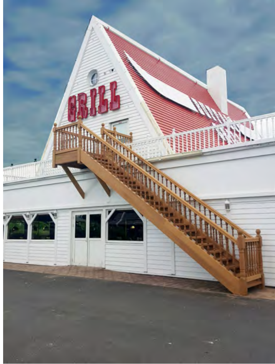
Escalier extérieur Marches en iroko Poteaux bois, balustres tournés
