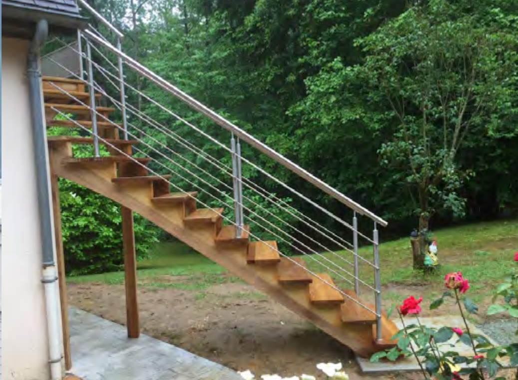
Escalier extérieur Limon central en iroko Marches en iroko Poteaux en inox
