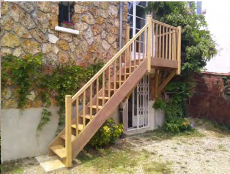
Escalier extérieur traditionnel Marches en iroko Poteaux bois, balustres en bois
